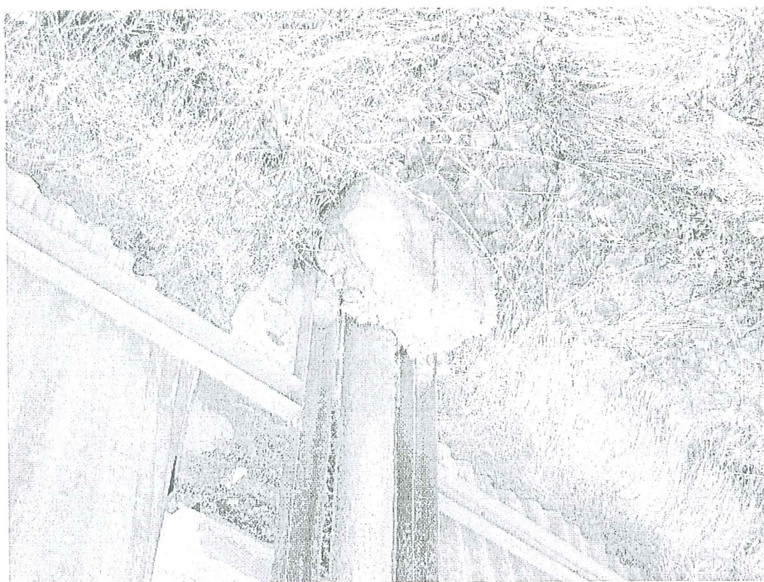
—Obetonowanie rur (wieszaków) od strony południowej w kilku miejscach zniszczone co naraża je na szybszą korozję
